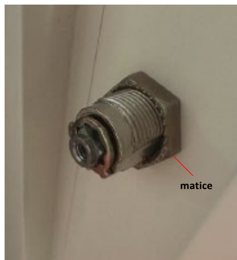
5. Matici pevně utáhněte, aby zámek držel na zadní straně dveří.
