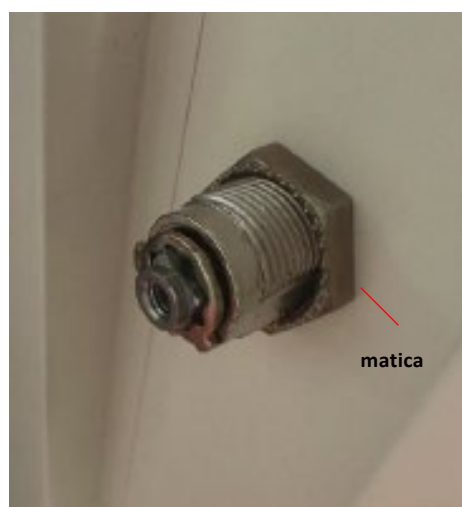
5. Maticu pevne dotiahnite, aby zámok držal na zadnej strane dverí.
